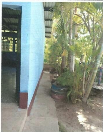
Foto1: FOTOGRAFÍA DE ÁREA A INTERVENIR PARA ESTRUCTURA TIPO PÓRTICO AREA FRONTAL
